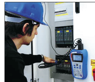
Un dispositif d'accrochage astucieux qui permet de travailler "mains libres"
